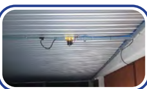
電気キャビネットのバルブを取り付ける
