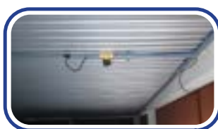
Lắp van tủ điện
