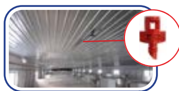
Béc phun được lắp đặt trong chuồng trại
